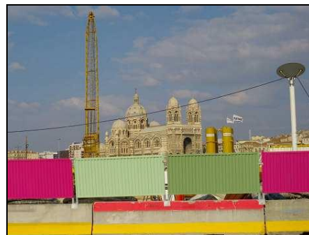
Vue du J4 : La Major et les travaux d'Euroméditerranée (mars 2010)
